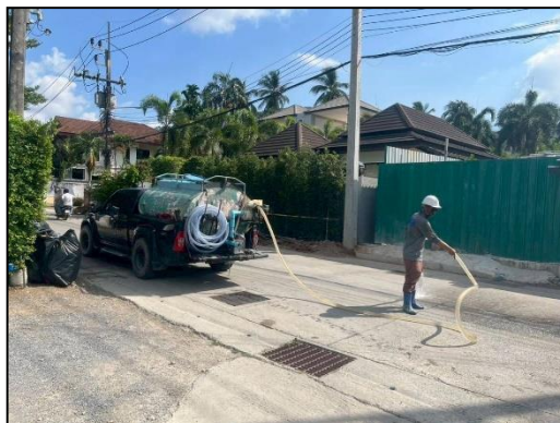
ภาพที่ 28 กิจกรรมฉีดพรมน้ำบริเวณเส้นทางขนส่งวัสดุก่อสร้าง
