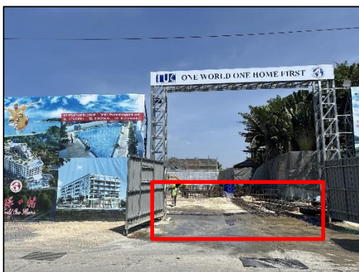
ภาพที่ 5 พื้นที่ล้างล้อ และกิจกรรมฉีดล้างล้อรถบรรทุก
